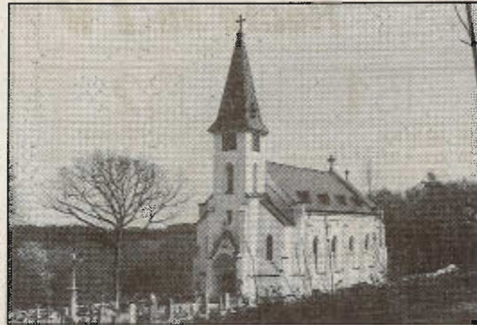
Während die ehemalige Pfarrkirche von Glöckelberg nahezu wiederhergestellt ist...
