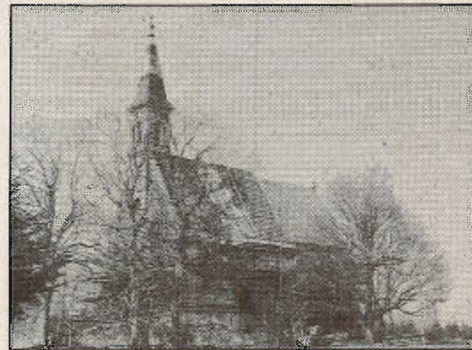
... befindet sich die gotische Kirche St. Thoma noch in einem erbarmungswürdigen Zustand.
