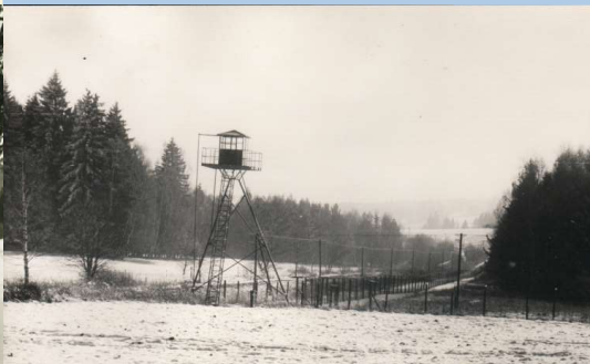
Grenzsperrn mit einem Beobachtungsturm bei Glöckelberg, 1989. Foto: Jan Štětina.
